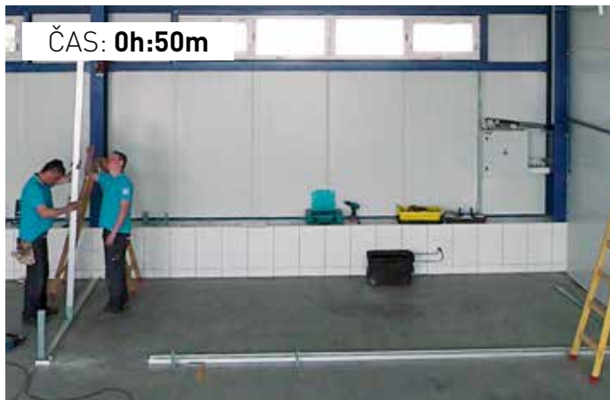
Založení obvodové konstrukce
