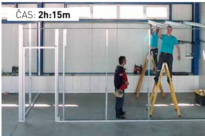
Montáž konstrukce stropu
