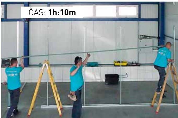
Montáž pomocné konstrukce
